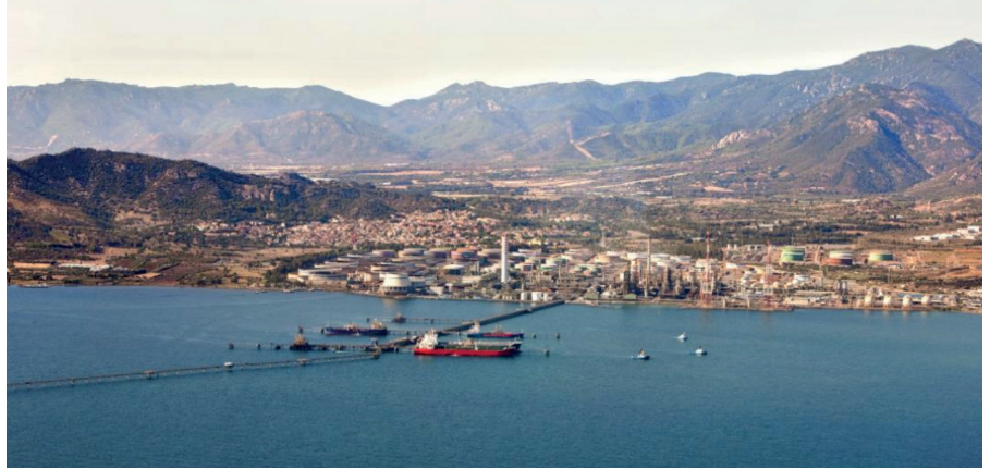
Figura 34 Fotografia della Raffineria della Saras a Sarroch in provincia di Cagliari
