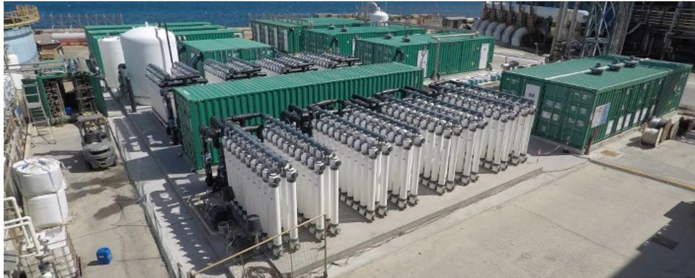
L'impianto ha una capacità produttiva giornaliera di 12,000 m<sup>3</sup> di acqua demineralizzata attraverso processi di ultrafiltrazione, osmosi inversa e elettrodeionizzazione.
