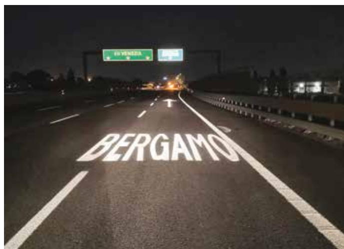
1. Il Parlamento Europeo ha sottolineato l'importanza delle prestazioni della segnaletica orizzontale per l'efficacia dei sistemi di assistenza alla guida (photo credit: Andrea Baiguini)
