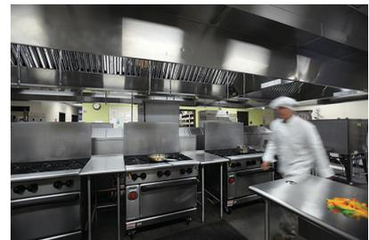
All'interno di queste cucine si viene a creare un elevato carico di incendio a causa della compresenza di olii di cottura sedimenti grassi nella zona filtri, nelle apparecchiature di cottura e nelle condotte di aspirazione con molteplici fonti di innesco.
