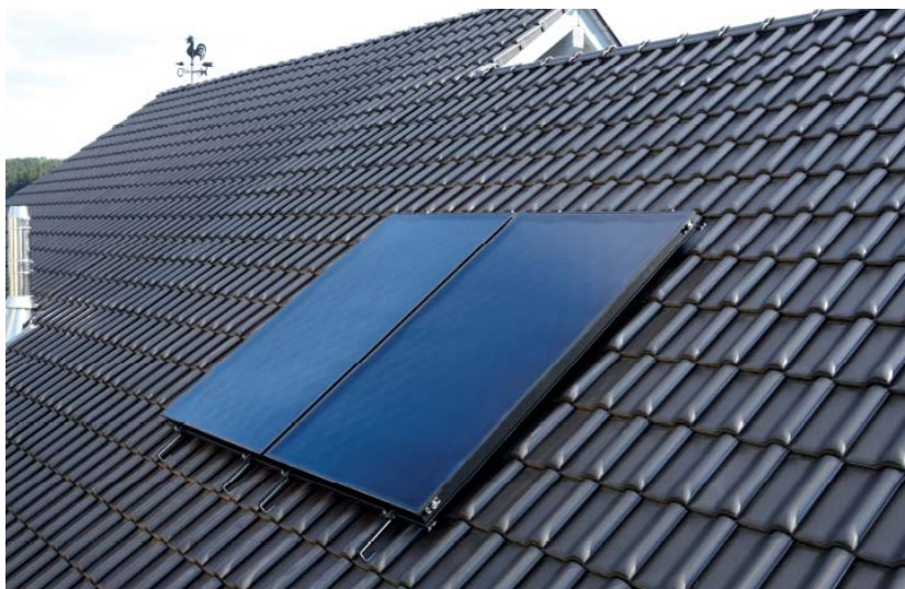
Fig. 3.5 Collocazione su tetto inclinato
