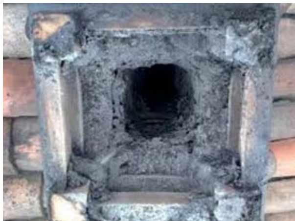
Fig. 2.6 - Esempio di camino esistente in cemento
