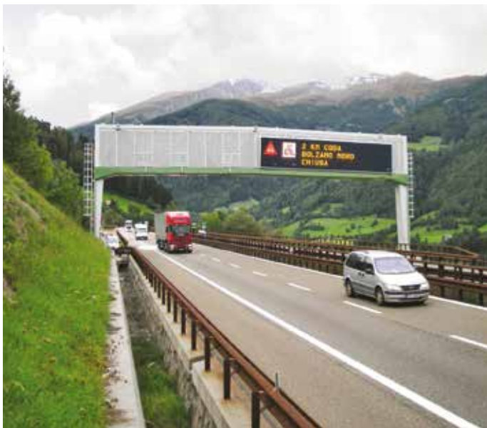
2. In ambito autostradale, un involucro del PMV alfanumerico e del PMV a doppio pittogramma realizzati da un unico contenitore chiuso, anche sul frontale
