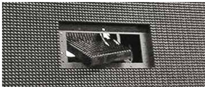
4A, 4B, 4C e 4D. La rimozione di una mattonella "spinta" verso l'esterno (vista dal fronte del PMV): è evidente il potenziale pericolo sull'utenza in transito sotto il PMV
