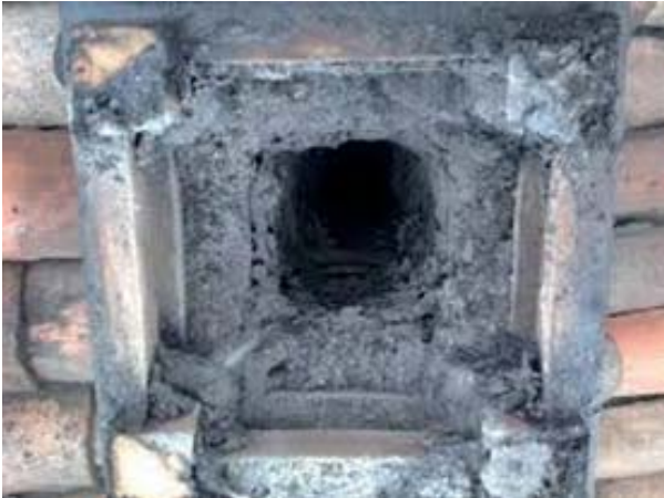
Fig. 2.7 - Esempio di camino esistente in cemento
