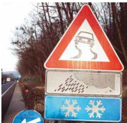
3. Un esempio di segnaletica verticale permanente non conforme
