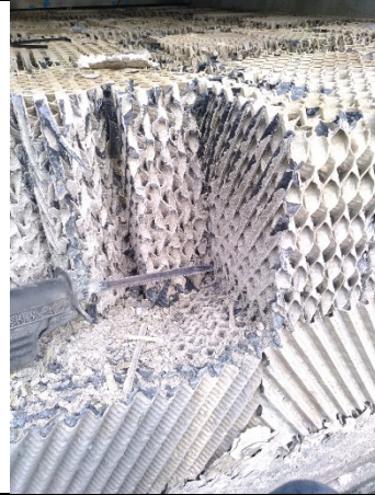
Figura 9: Interventi di demolizione
