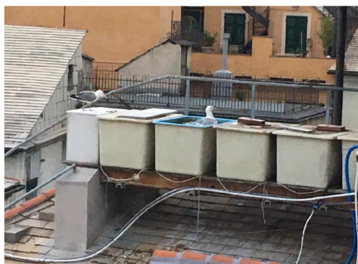
Fig.6: Serbatoi a tetto per acqua potabile sprovvisti di adeguate coperture
