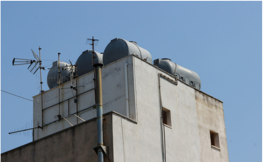
Fig.5: Serbatoi di acqua potabile sul tetto di un edificio
