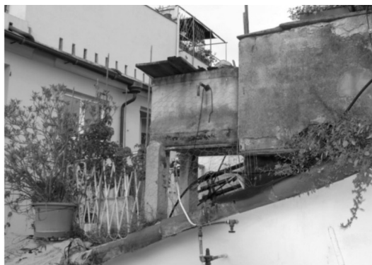
Fig.6: Serbatoi a tetto per acqua potabile sprovvisti di adeguate coperture
