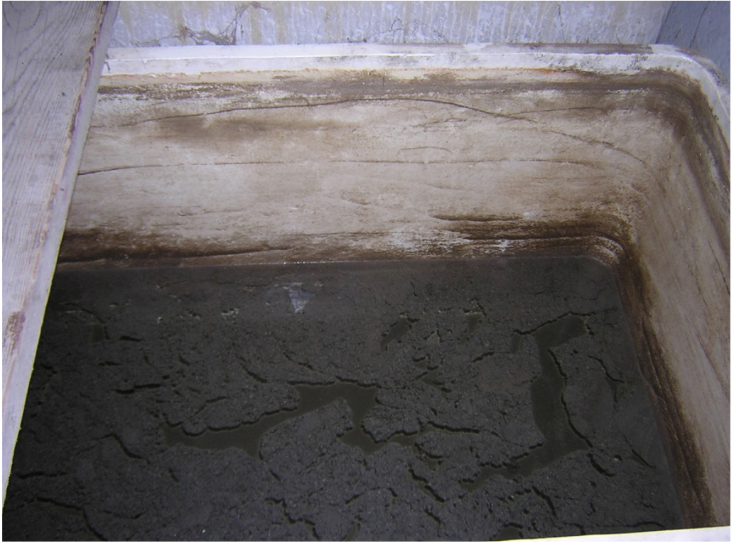
Fig.4: Vasca per l'acqua potabile con evidenti depositi e materiale in sospensione
